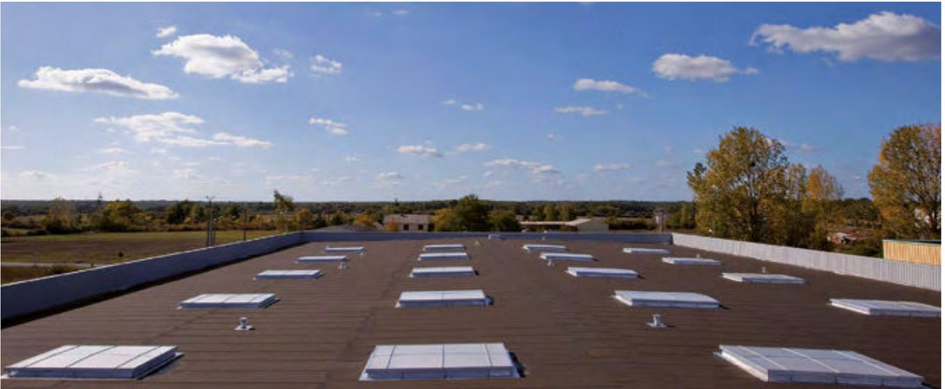
**Exemple 2 : lanterneaux correctement isolés assurant une autonomie de 300 lux 50% du temps pour un local commercial éclairé à 1 000 lux avec climatisation**
