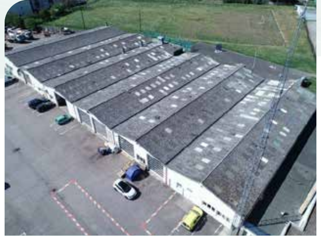
Vue d'ensemble du bâtiment avant travaux
