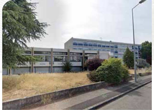
Vue d'ensemble des bâtiments avant réhabilitation
